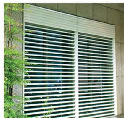
平掛式 (BUILT-IN) 裝在室外牆洞上，百葉收納箱朝外。
